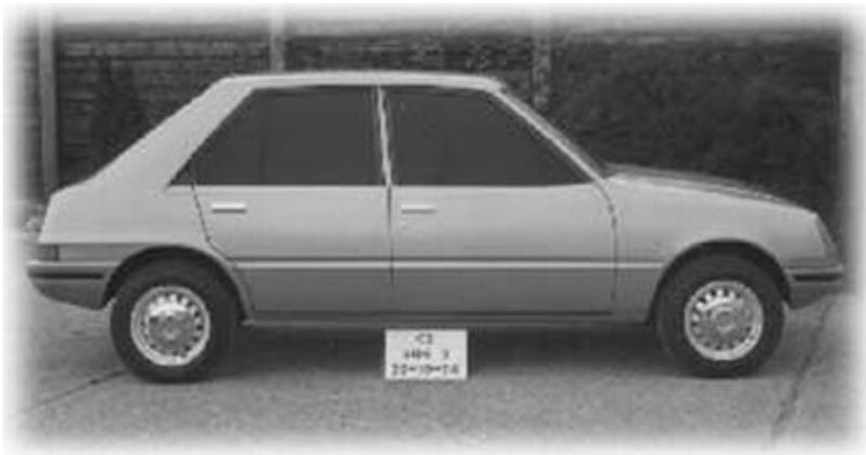
Uno de los prototipos del proyecto C2 de 1974, del que nacerían el Simca Horizon y el futuro sustituto del Simca 1000. Puede observarse su parte trasera, con ligera caída a dos niveles, en una clara inspiración del Simca 1100.
